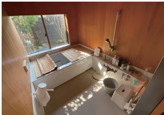
壁：ひのき板張り： 使用後に拭上げ、換気・乾燥をし使用10年経過の様子
